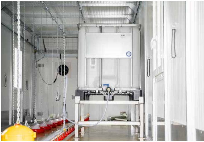
Réservoir d'eau de 1000 litres
