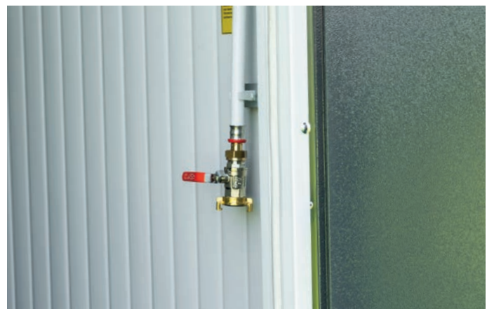
Connection au réseau d'eau dans la pièce séparée
